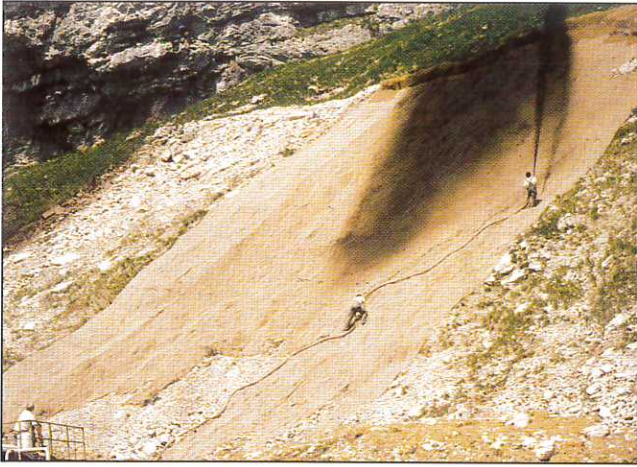
Spritzbegrünung eines Hangabbruches mittels Humusemulsion und Alpinsaatzgut
