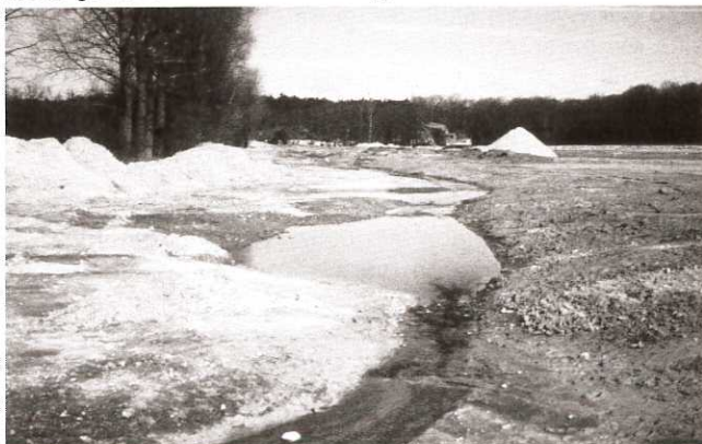
Abb. 1: Bachausbau (Golfplatz Dassendorf).
