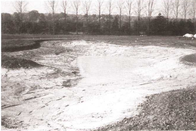
Abb. 6: Beregnungsteich im Bau (Golfplatz Ahaus).
