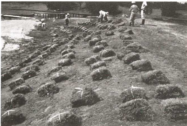
Abb. 1: Verlegung von Fertigrasen auf dem Glenmoor Golfplatz, welcher von dem amerikanischen Golfdesigner Peter Dye geplant wurde.
