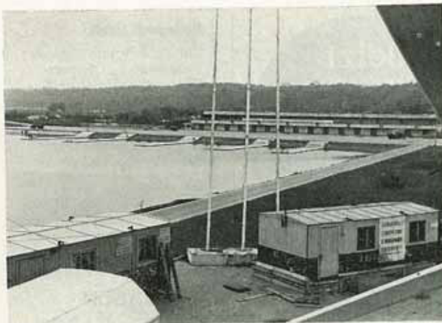
Abb. 3 Die Anlage für die Ruderer ist fast fertiggestellt, die Baubuden werden bereits demontiert.
