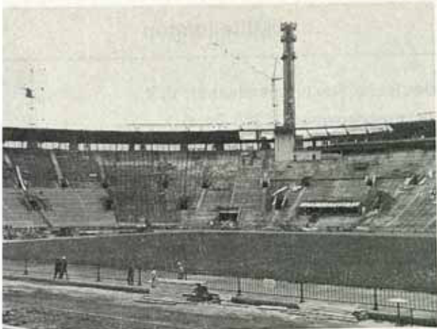
Abb. 1 Das Lenin-Stadion ist z. Zt. noch eine einzige Baustelle mit den Hochkränen und einer Vielzahl von arbeitenden Menschen.
