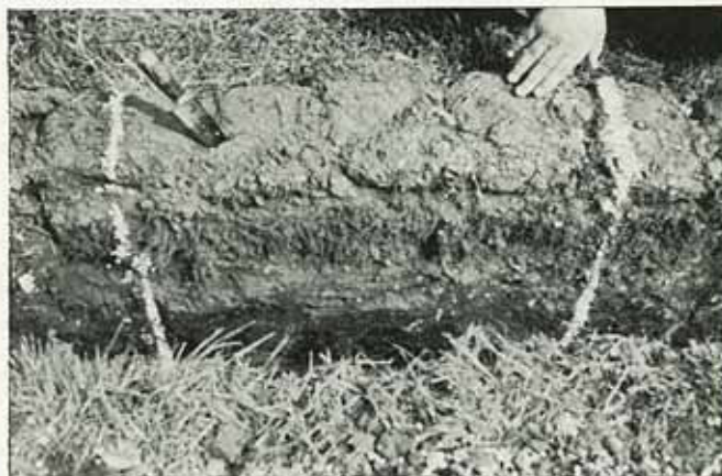
Bild 8 Aufgegrabene Drainschlitz, Chantilly
