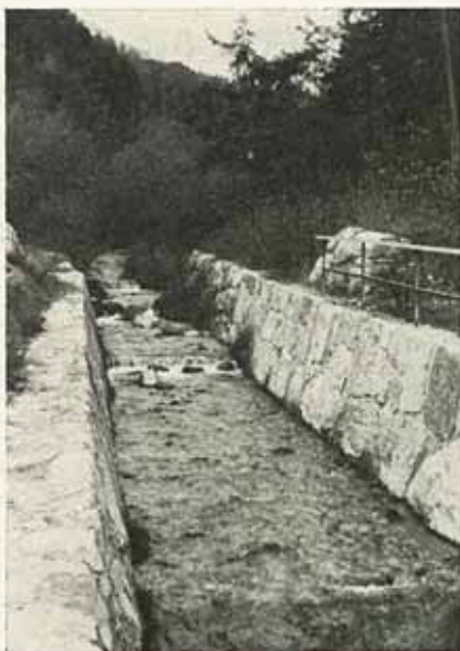
Abb. 1: Im Vordergrund: Regulierung in Zementmörtel- mauerwerk mit totem Material. Im Hintergrund: Steinregulierung mit Fugen- und Kronenbegrünung aus lebendem Material
