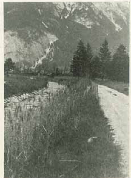
Abb. 2: Regulierung mit Schilfbewuchs im oberen Teil der Böschung
