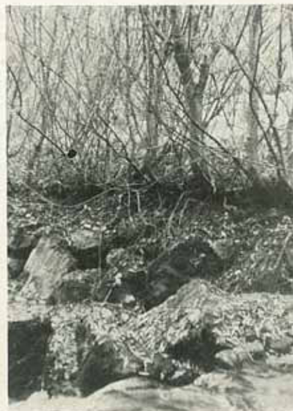
Abb. 5: Kronengrünverbauung bei einer grob geschichteten Trockenmauer. Die Wurzeln der Weiden befestigen die Steine und schützen sie bei Hochwasser vor Abschwemmung
