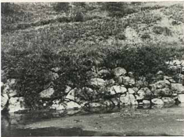
Abb. 3: Die unbearbeiteten Kalksteine sind durch Hängepflanzen teilweise abgedeckt. Eine Erdmaterialfüllung in den Fugen fehlt
